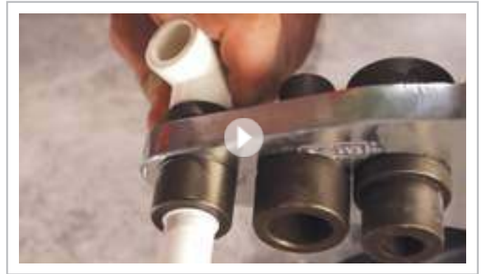
Монтаж полипропиленовых труб.
